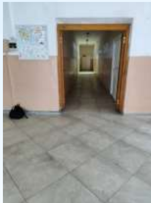
МКОУ Русановская ООШ - ремонт напольного покрытия и отопления на 1 этаже здания на сумму 1 000 000 рублей.
