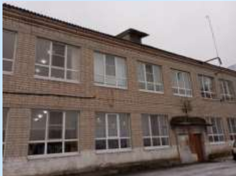
МКОУ Терновская СОШ №2 – замена оконных блоков на сумму 200 000 руб.
