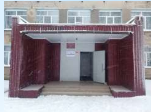
МКОУ Дубровская ООШ- ремонт входной группы на сумму 503 000 рублей
