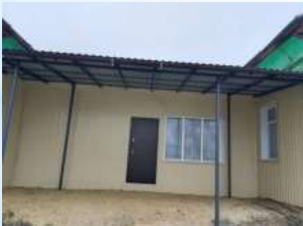
МКОУ Линяговская ООШ- ремонт входной группы на сумму 500 000 рублей.
